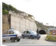
Strada Statale 522 Quella galleria è un rischio Francesco Barritta (pag. 3)
